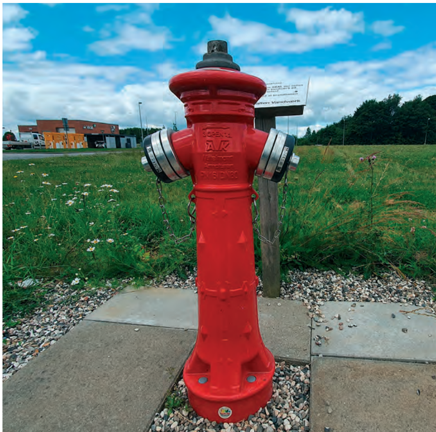
Hidrante con VIDI Caps instalados. El uso de un hidrante afecta profundamente a la presión en la zona. Por tanto, es importante que la empresa de aguas sepa cuándo se está utilizando el hidrante para distinguir entre una caída de presión que proviene del uso regular o de una rotura en la tubería.
