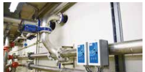
Después de la fermentación, el lodo se transporta a un almacenamiento de tampón de lodo antes del desagüe final.
