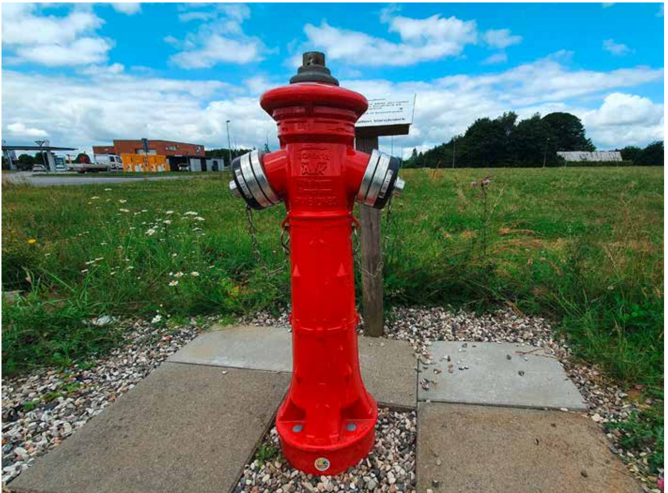
Hidrante con VIDI Caps instalados. El uso de un hidrante afecta profundamente a la presión en el área. Por tanto, es importante que la empresa de aguas sepa cuándo se está utilizando el hidrante para distinguir entre una caída de presión que proviene del uso regular o de una rotura de tubería.
