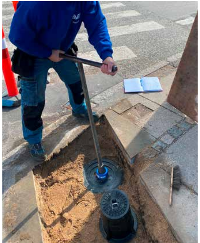
Válvula de compuerta enterrada con la indicación de un VIDI Positioner que detecta cuando se opera la válvula.
