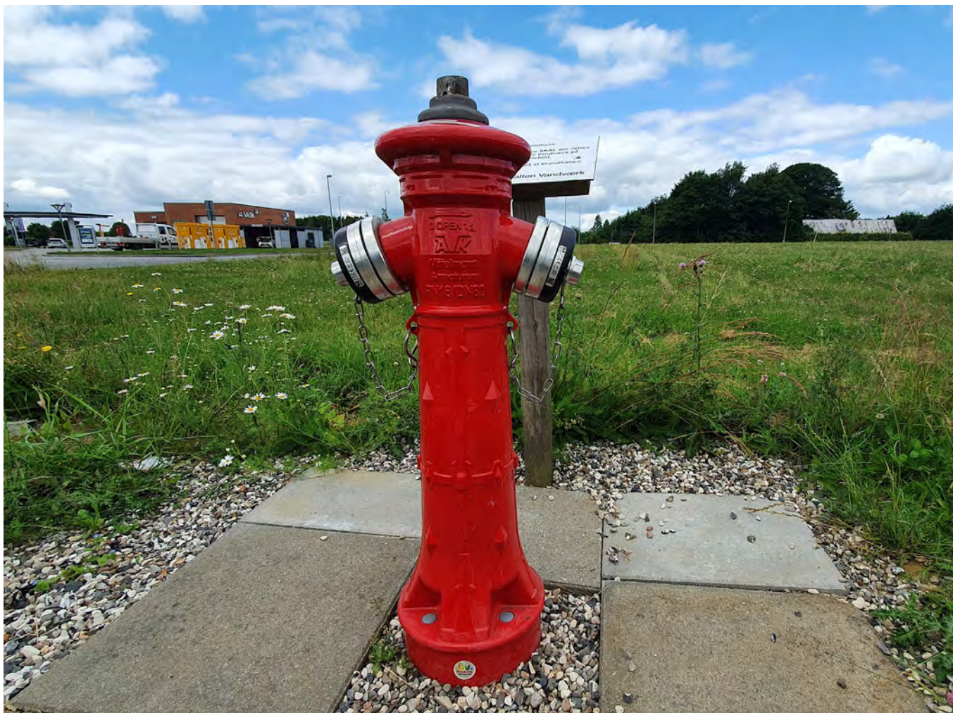
Hidrante con VIDI Caps instalados. El uso de un hidrante afecta significativamente a la presión en el área. Por tanto, es importante que la empresa de aguas sepa cuándo se está utilizando el hidrante para distinguir entre una caída de presión que proviene del uso regular o de una rotura de tubería.
