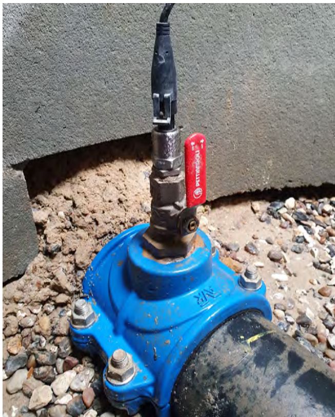
Debido a la naturaleza inalámbrica de IoT, los sensores de presión se pueden instalar en cualquier punto crítico de la red de distribución.
