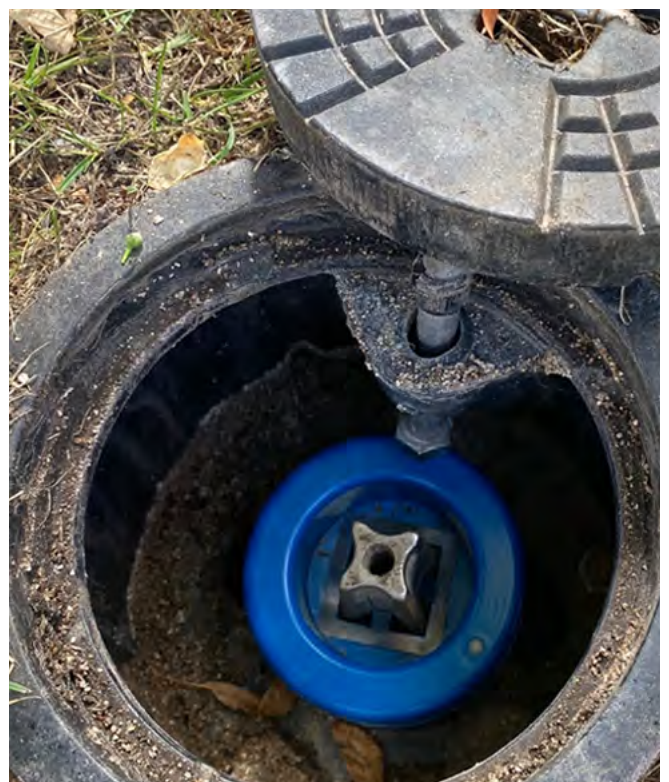
VIDI Positioner instalado en una boca de llave.
