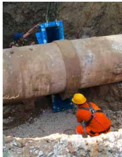
En abril de 2019, el Departamento Técnico de Acquedotto Pugliese S.p.A. nos pidió que organizáramos una inspección técnica de la tubería de Sifone Leccese. Era necesario encontrar una solución para reparar una fuga grave en la unión de la tubería de hormigón.
