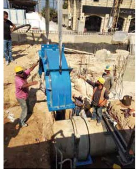
Collares de encapsulamiento Hydro Fast utilizados para proteger dos uniones acampanadas en una tubería de hormigón en la ciudad de Beirut (Líbano).
