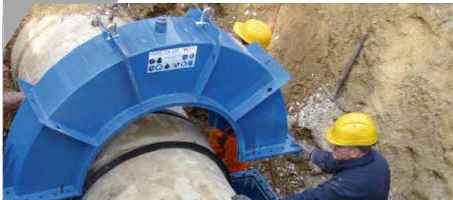
Collar de encapsulamiento Hydro Fast utilizado para reparar una unión con fugas en una tubería de hormigón antigua y frágil situada en Apulia, en el sur de Italia.
