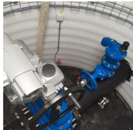
La ventosa solo se cierra cuando llega agua y levanta el flotador en contacto con el cierre.
