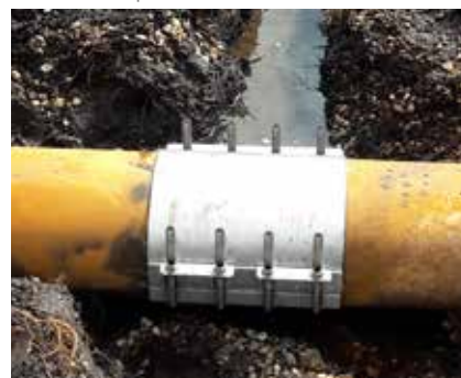
Después de la reparación
